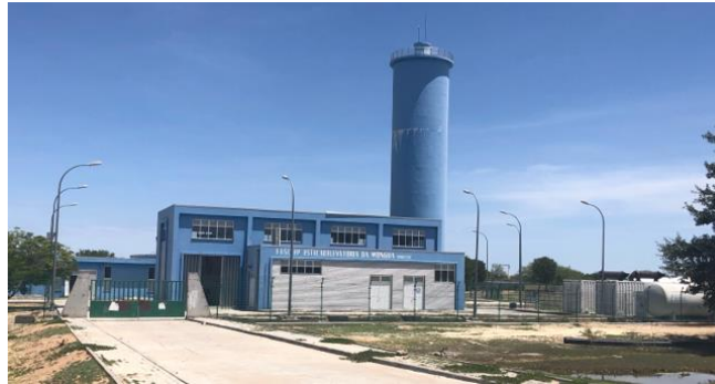
Figura 5. Central Elevatória de Môngua
