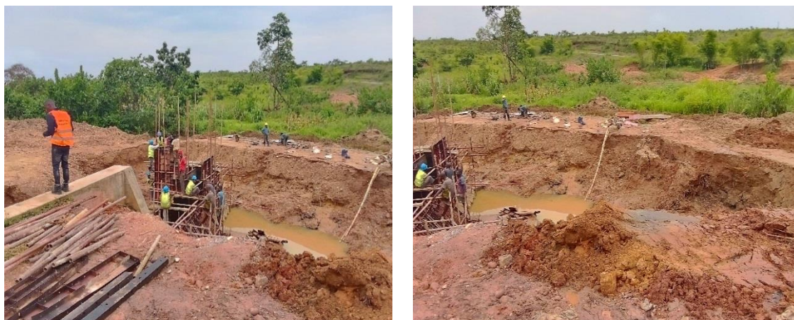
Fotografia nº 2. Trabalhos de construção da barragem do novo SAA
