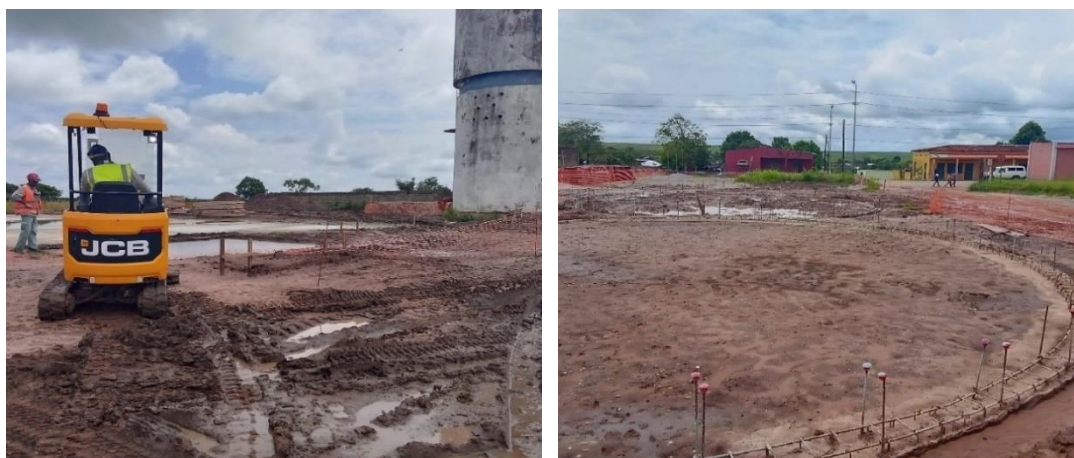
Fotografia nº 1. Trabalhos na área definida para a construção da ETA do novo SAA
