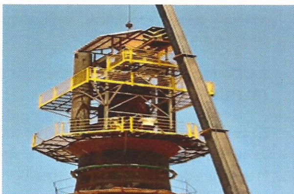
Foto 4: Montagem da chaminé do alto-forno
