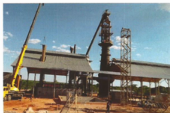
Foto 2: Montagem da infraestrutura do alto-forno
