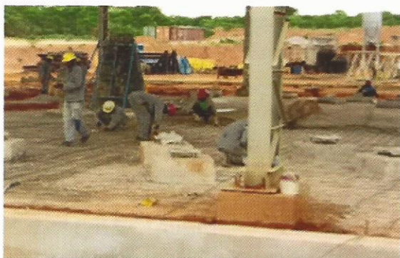
Foto 5: Construção de infraestruturas
